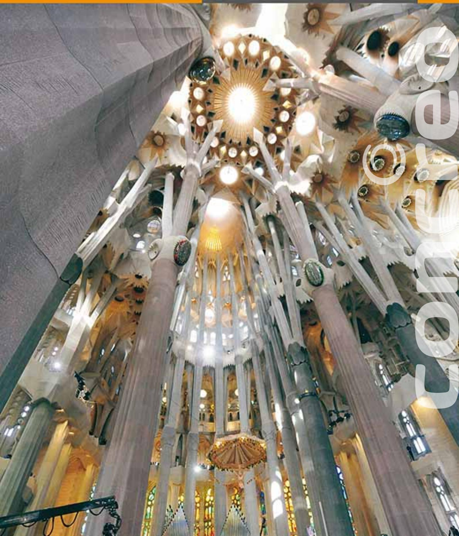
La Sagrada Família ha una pianta basilicale a croce latina con cinque navate longitudinali e tre trasversali. La lunghezza del tempio è di 95 metri, la larghezza della navata principale è di 15, quelle laterali di 7,5 metri: la larghezza complessiva è perciò di 45 metri. Il transetto è lungo 60 metri e largo 30. L'abside ha sette cappelle radiali e un deambulatorio ed è sovrapposto alla cripta in stile neogotico, progettata
