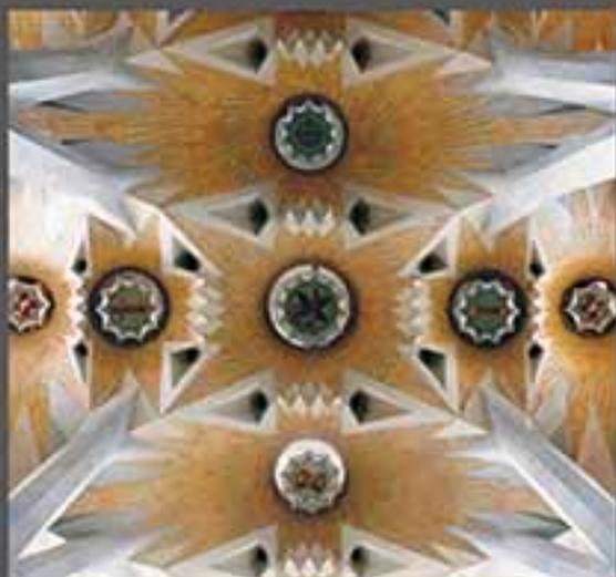
*L'interno del tempio sarà come un bosco. La struttura delle navate lo dice e tale rassomiglianza è stata raggiunta senza ricerca apposta. I pilastri sono elicoidali e leggermente inclinati: elicoidali, perché questa è la forma propria che accoglie il carico superiore, e inclinati, perché il carico spinge con una certa inclinazione proveniente dalle funicolari delle volte e delle coperture.*
