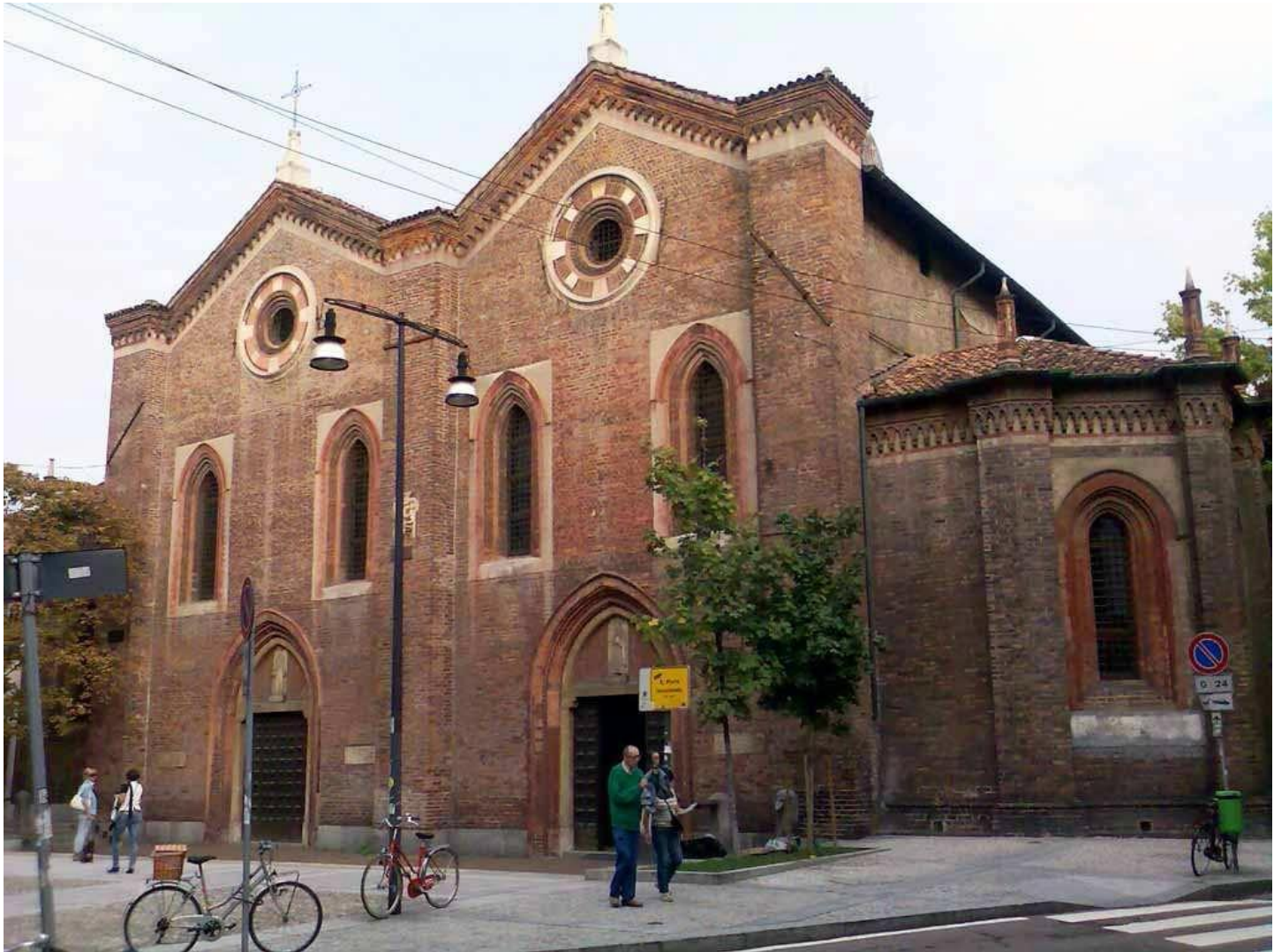
Milano, Chiesa di Santa Maria dell'Incoronata, C.so Garibaldi.
